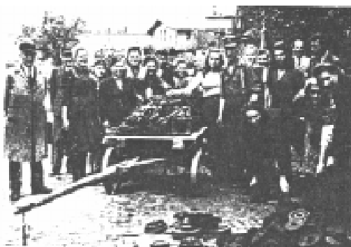
Przewóz maszyn do ustawienia w hali 5.X.1947r
