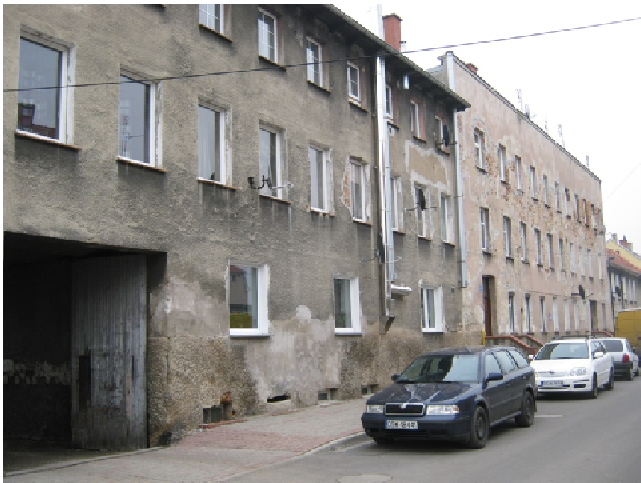
Obecny widok dawnej fabryki zegarów H. Endlera przy ul. Granicznej (zdjęcie autora).
