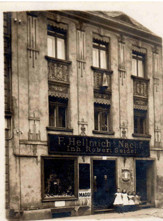
Budynek przy ulicy Stefana Żeromskiego 21 Ze zbiorów Waldemara Krynickiego
