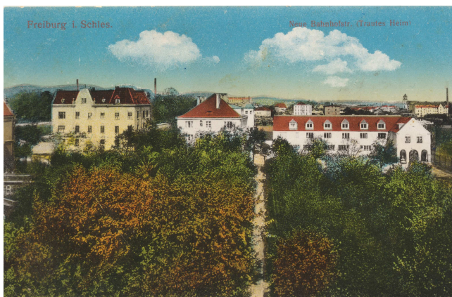
Ulica Kolejowa - widok od strony zakładu „Rafio”
